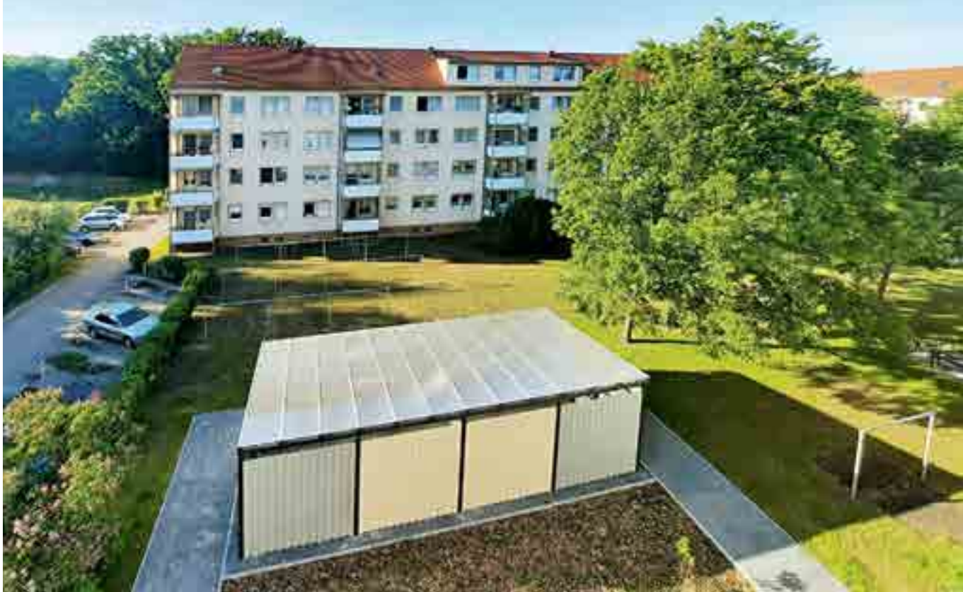
Für das Projekt ausgesucht wurden ganz normale Wohnhäuser aus der Nachkriegszeit. In diesem Wohnblock der GWG Lübben wurde die smarte Technik erfolgreich getestet
