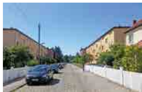
In diesen Blocks der ABG Paradies wurden Raumsensoren und smarte Ventilregler eingesetzt
