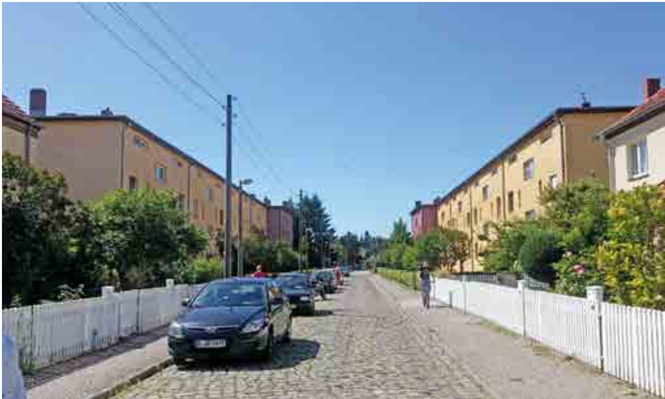
In diesen Blocks der ABG Paradies wurden Raumsensoren und smarte Ventilregler eingesetzt
